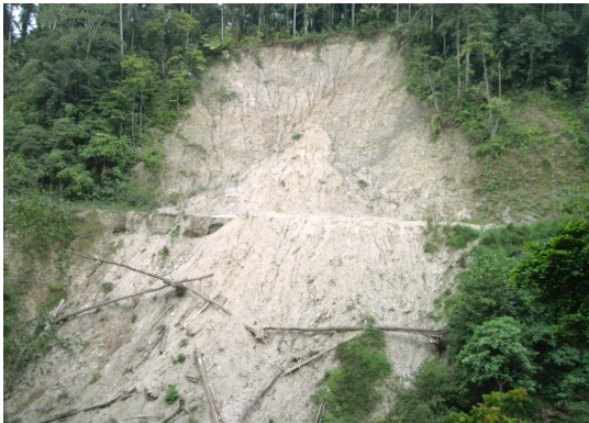
Gambar 16. Gerakan tanah dimensi besar di Desa Salua, Kecamatan Kulawi, Kabupaten Sigi. Gerakan tanah ini mengancam jalan yang menghubungkan antar desa di Kecamatan Kulawi.
